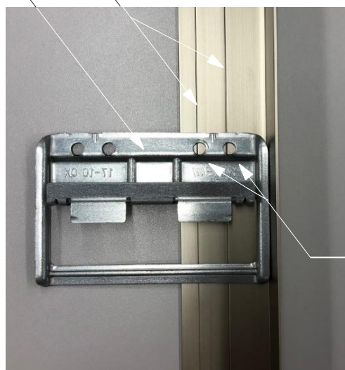
L-образная алюминиевая односторонняя стыковочная планка
